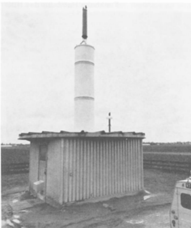
Sendergebäude mit Einelementantenne
