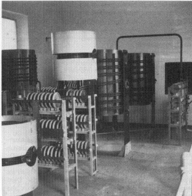
Im Antennenhaus kann man die Kondensatoren und Spulen erkennen, die das Siebglied bilden. Das „Wasserrohr“ ist die Antennenleitung. Neben an befindet sich die große Spule zum Antennenanpassen.
